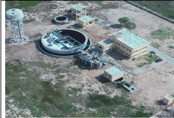
4 MLD STP, Tonk
