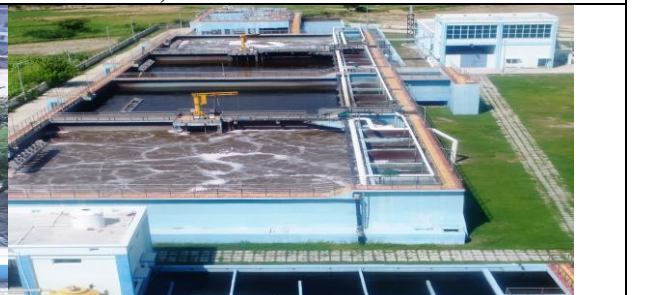
24 MLD STP, Etah
