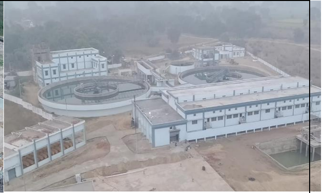
80 MLD WTP, Unnao
