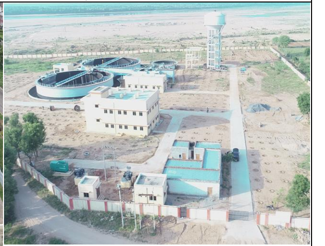
16 MLD STP, Tonk
