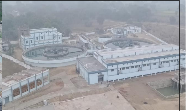
80 MLD WTP, Unnao
